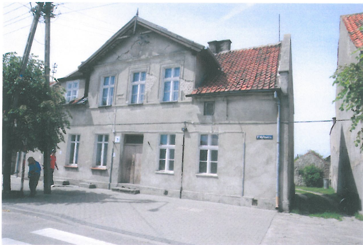
Fot. 1 Widok budynku - elewacja frontowa
