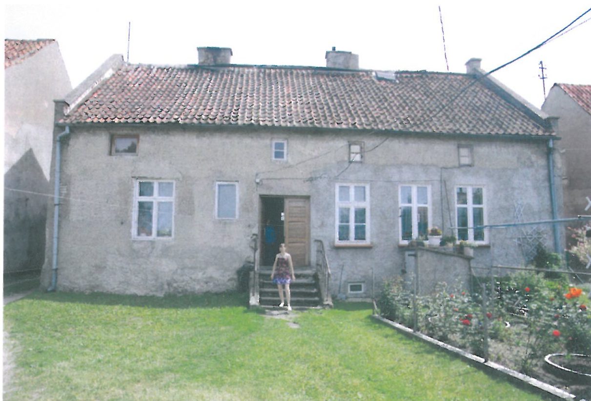
Fot. 2 Widok budynku - elewacja tylna
