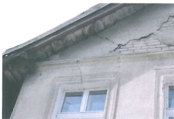
Fot. 3 Elewacje szczytowe – widoczne uszkodzenia ścian
