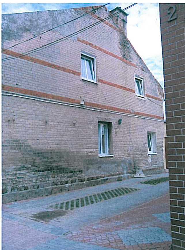
Fot. 3 Widok budynku - elewacja szczytowa
