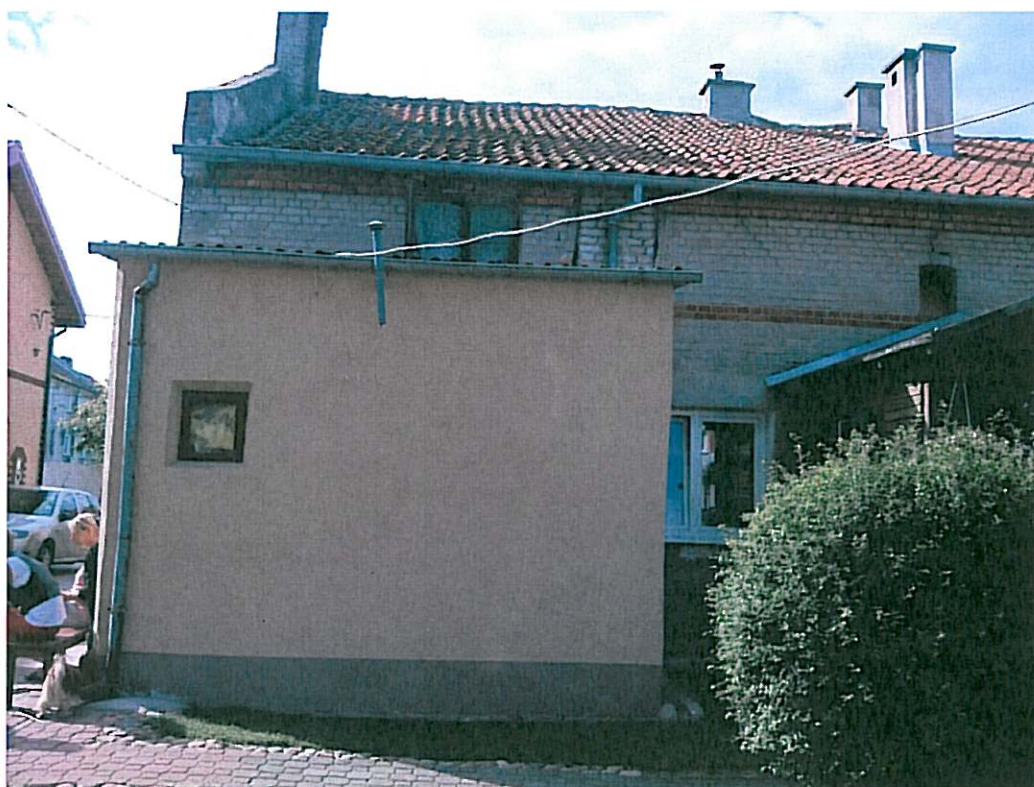
Fot. 4 Widok budynku- elewacja tylna
