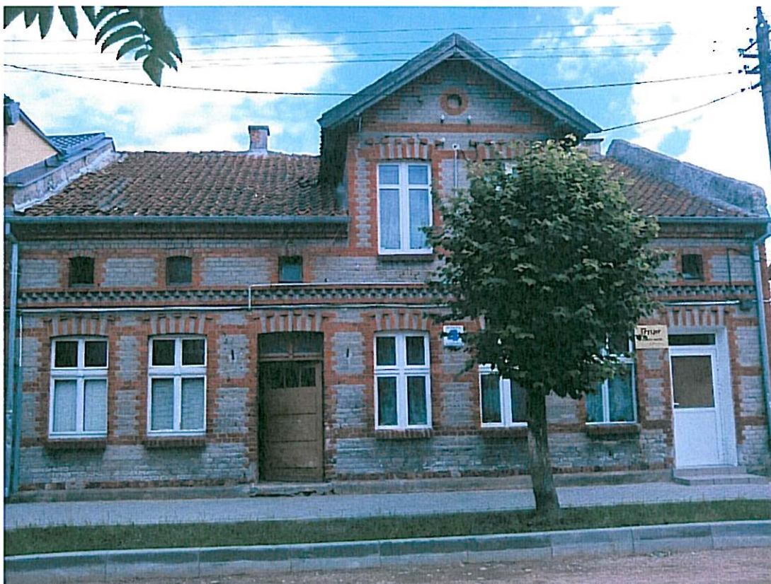
Fot. 1 Widok budynku - elewacja frontowa
