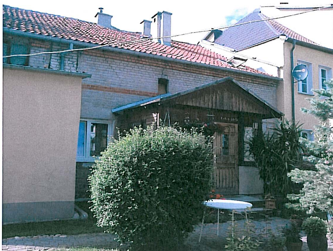
Fot. 2 Widok budynku - elewacja tylna
