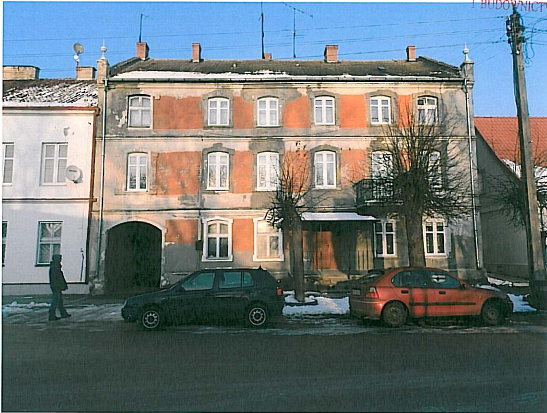
Fot. 1 Widok budynku - elewacja frontowa
