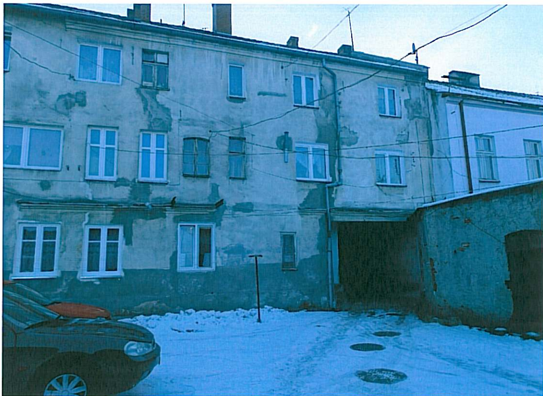
Fot. 2 Widok budynku - elewacja tylna
