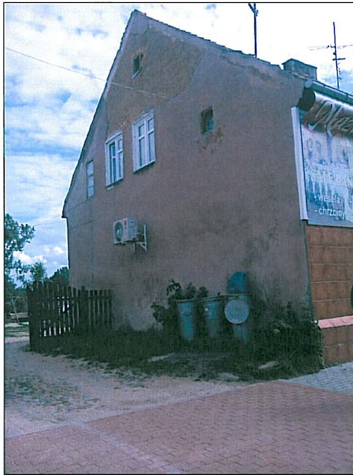
Fot. 3 Widok budynku - elewacja szczytowa
