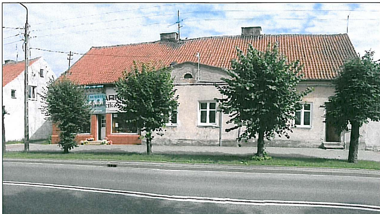
Fot. 1 Widok budynku - elewacja frontowa
