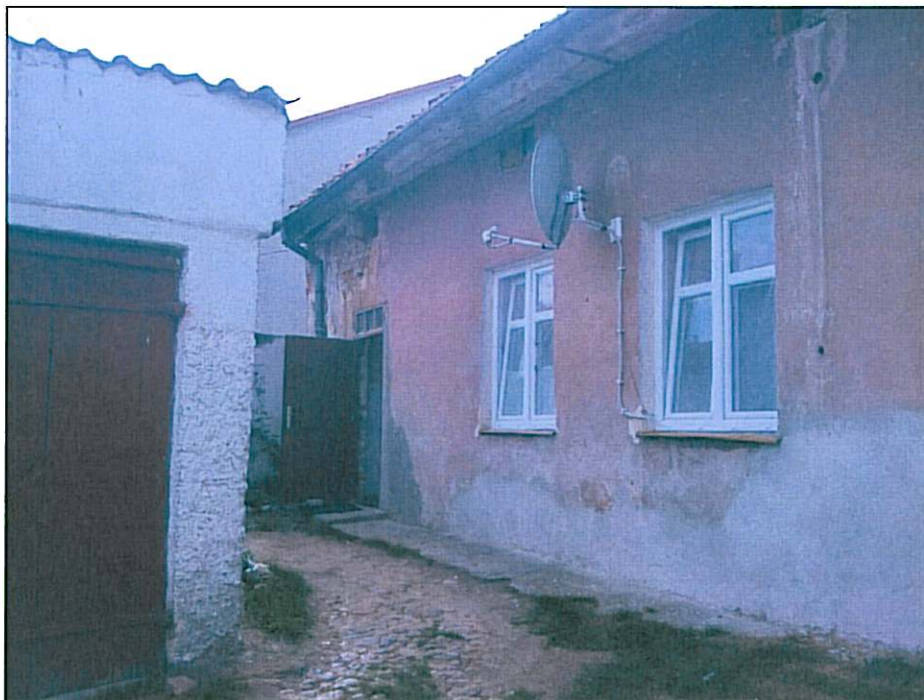
Fot. 4 Widok budynku- elewacja tylna
