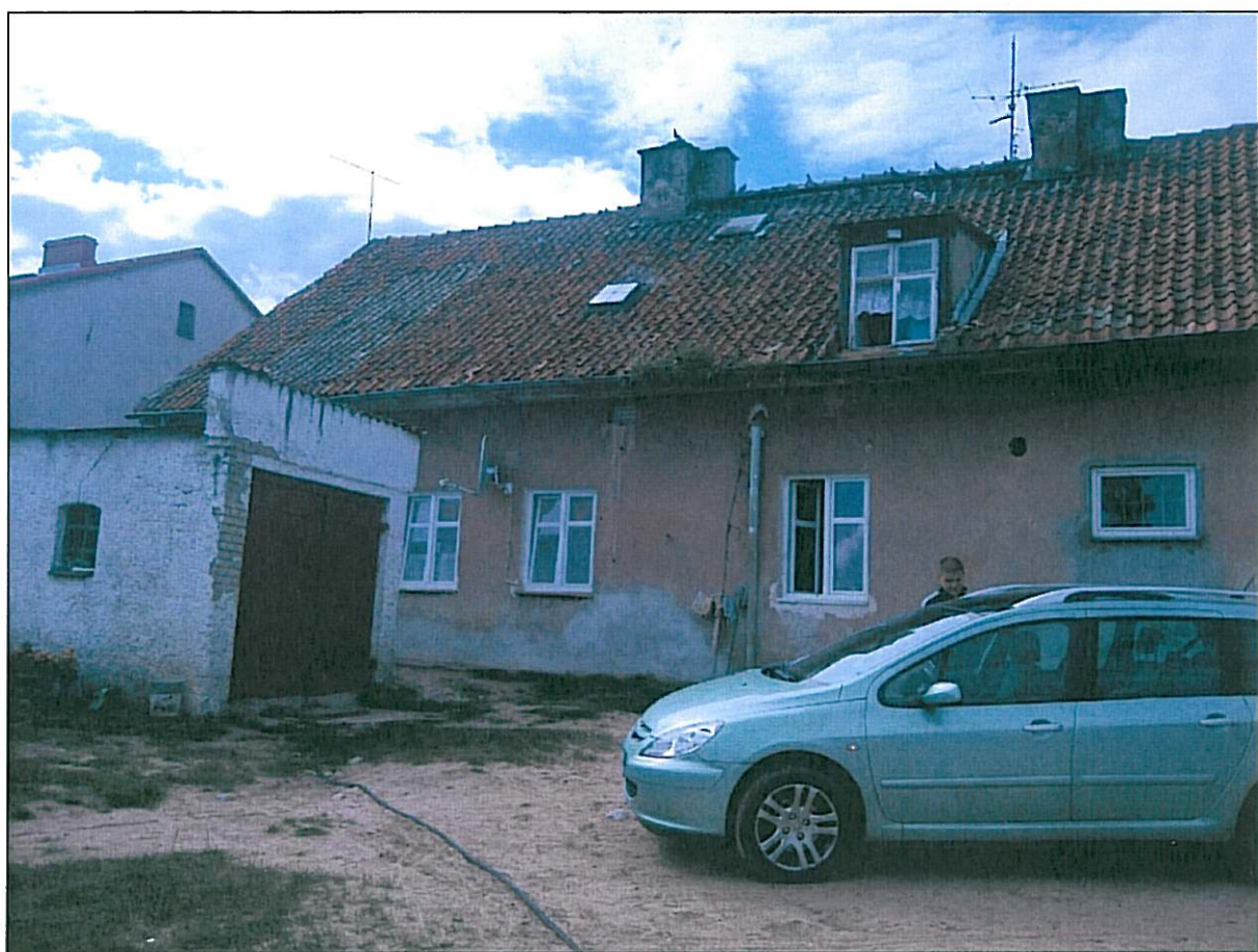
Fot. 2 Widok budynku - elewacja tylna
