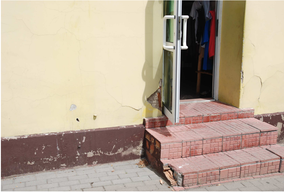
Fot. 6 Schody zewnętrzne podlegające remontowi (gres mrozoodporny)
