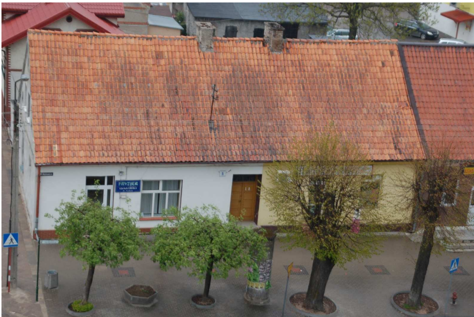
Fot. 7 Widok budynku od strony części usługowej
