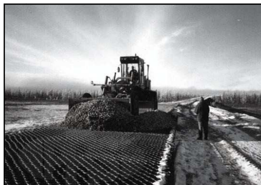
Rys. 6. Zасыpywanie kruszywem komórek geosiatki za pomocą równiarki
