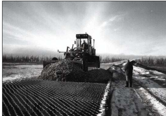
Rys. 6. Zасыpywanie kruszywem komórek geosiatki za pomocą równiarki
